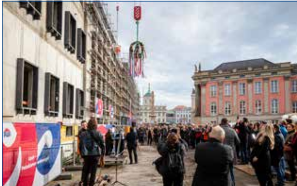
Richtfest in der Potsdamer Mitte (Foto: Benjamin Maltry)
