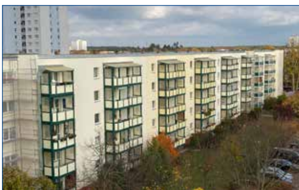
Fassadensanierung in der Galileistraße 1-17
