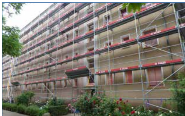
Fassadensanierung am Platz der Einheit 6-9
