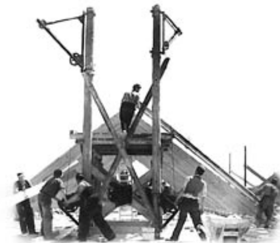
Genossenschaftsmitglieder beim Aufbau des Dachstuhles 1957 in der Fichtestraße
