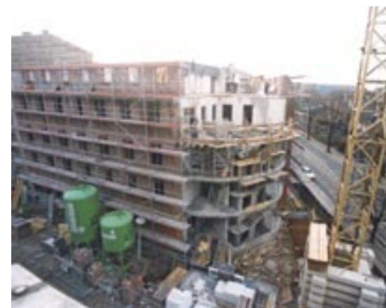
Bau der neuen Geschäftsstelle 1994/95
