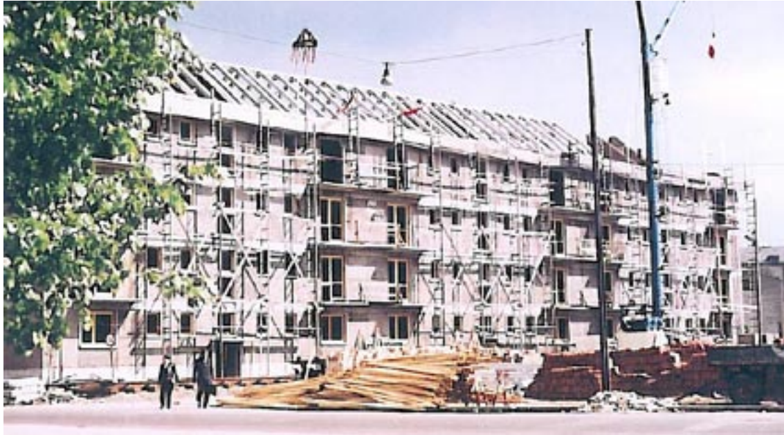
Richtfest für unsere Charlottenstraße 49 – 51
