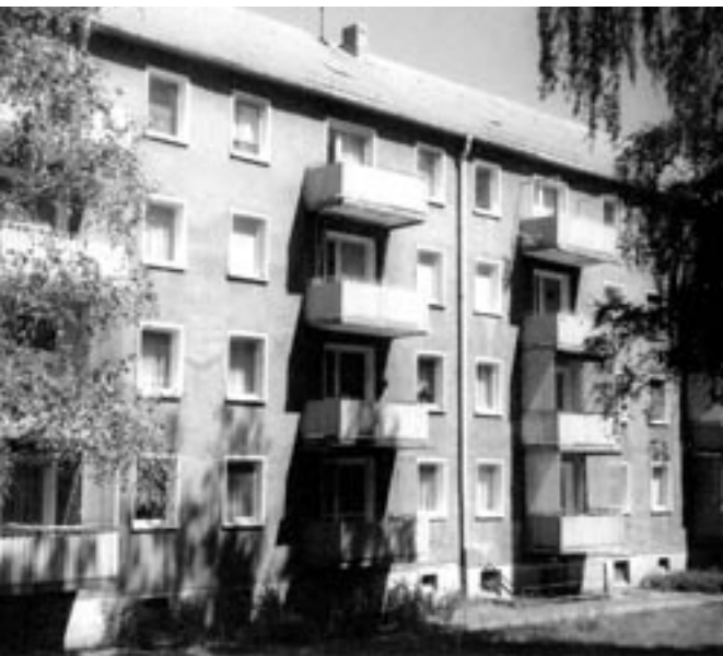
Bernhard-Kellermann-Straße vor der Sanierung
