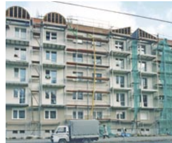
Endlich wird saniert
