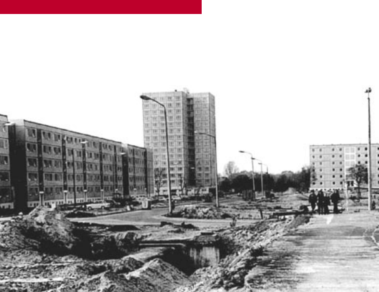
Bauarbeiten am Keplerplatz: Links im Bild die Galileistraße
