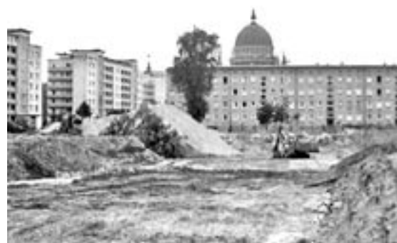
Das sogenannte Zentrum Süd entsteht: Burgstraße
