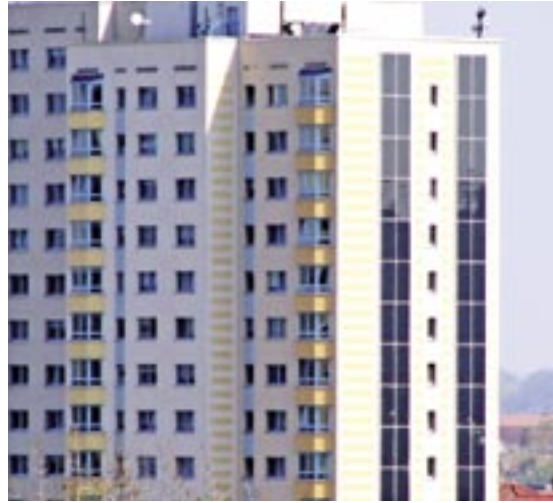
Blick auf die Breite Straße 23 mit der großflächigen Solaranlage
