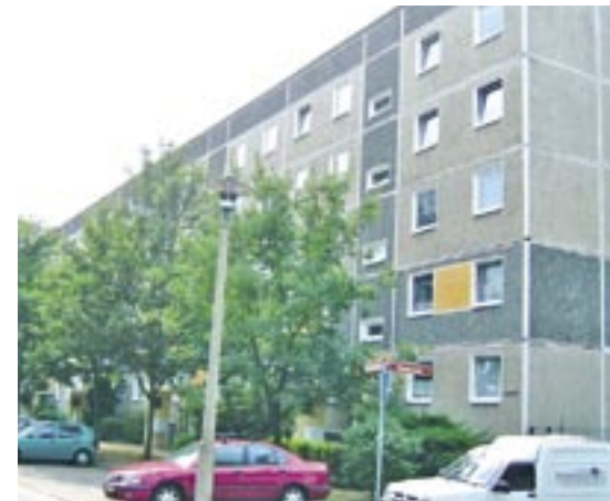
Die Saarmunder Straße vor der Sanierung
