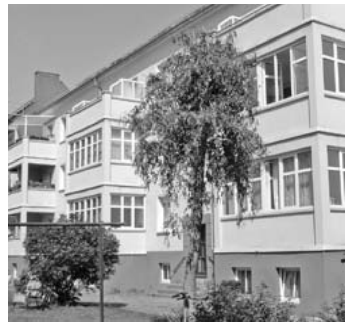
Die Hofseite des ersten Genossenschaftsgebäudes in der Kantstr. 22-24
