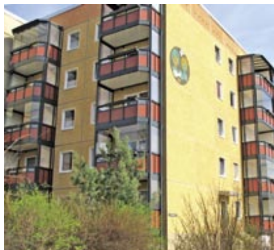
Am Nuthetal (links) und in der Konrad-Wolf-Allee blieben die typischen Fugen der Plattenbauten auch nach der Sanierung sichtbar
