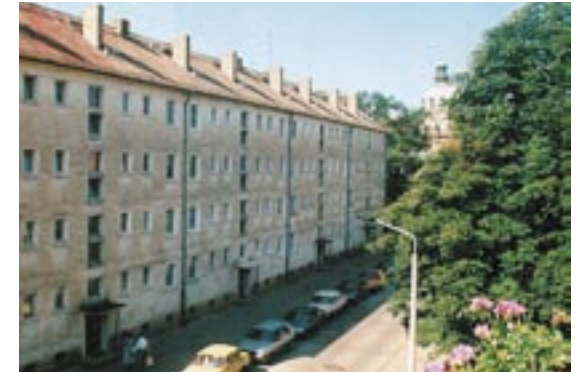
Die Behlertstraße im „Urzustand“ vor der Sanierung
