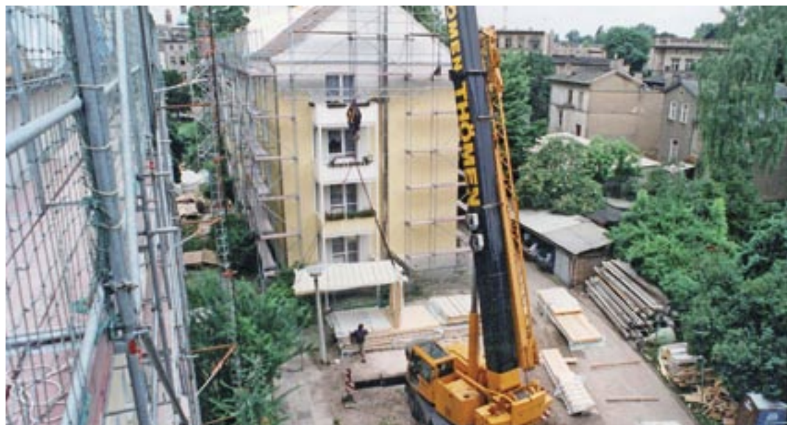
Dahgeschossaufbau in der Behlerstraße
