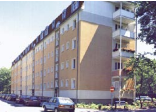
Behlertstraße nach Sanierung und Dachgeschossaufbau
