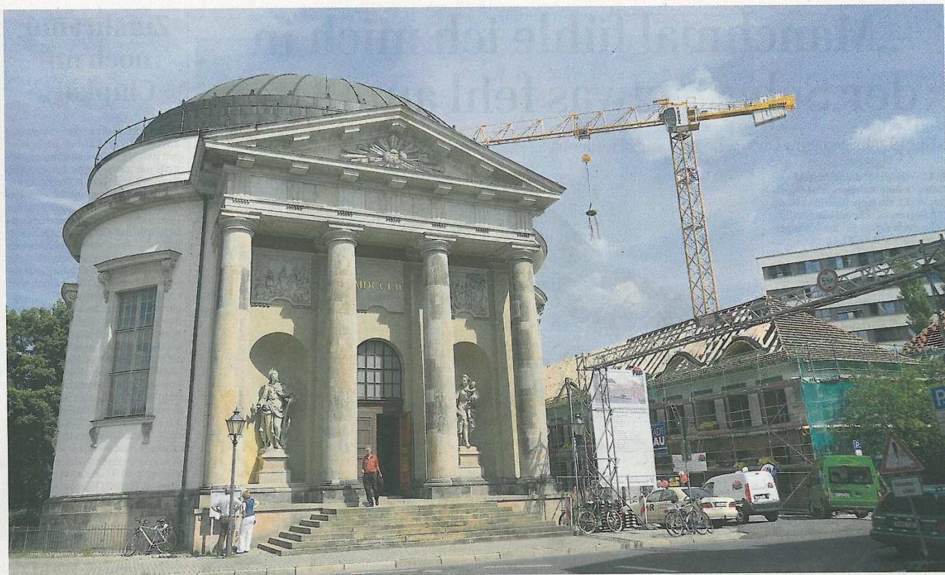
Die charakteristische Dachform der Holländerhäuser ist bereits im Rohbau erkennbar. Eine Höhenvermittlung zwischen Klinik und Kirche war indes unerwünscht. FOTO: B. GARTENSCHLÄGER
